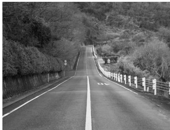
写真-2 縦断勾配錯視の例：香川県屋島ドライブウェイ、屋島ドライブウェイ株式会社との協力のもと撮影。(錯視の説明：近坂(手前道路)は下っているように見えるが、実は上り坂である)。
